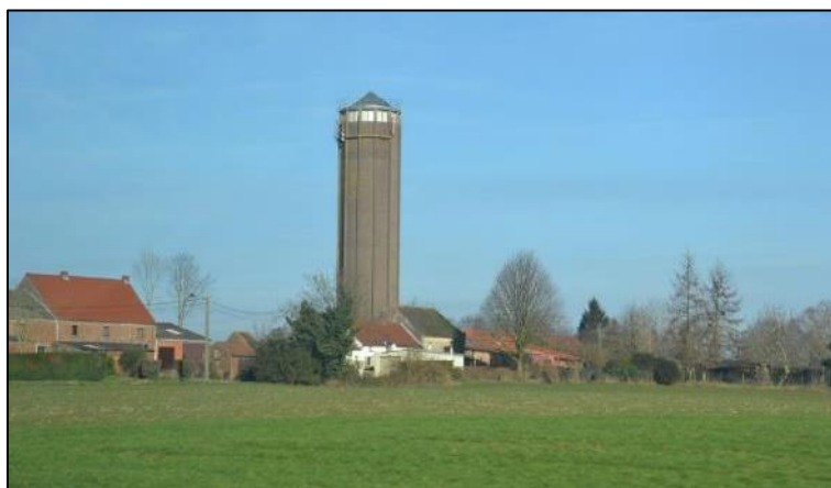
Château d'eau de Mauvinage © S&A - 2016
