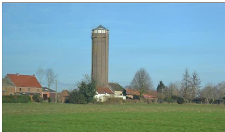
Château d'eau de Mauvinage © S&A - 2016
