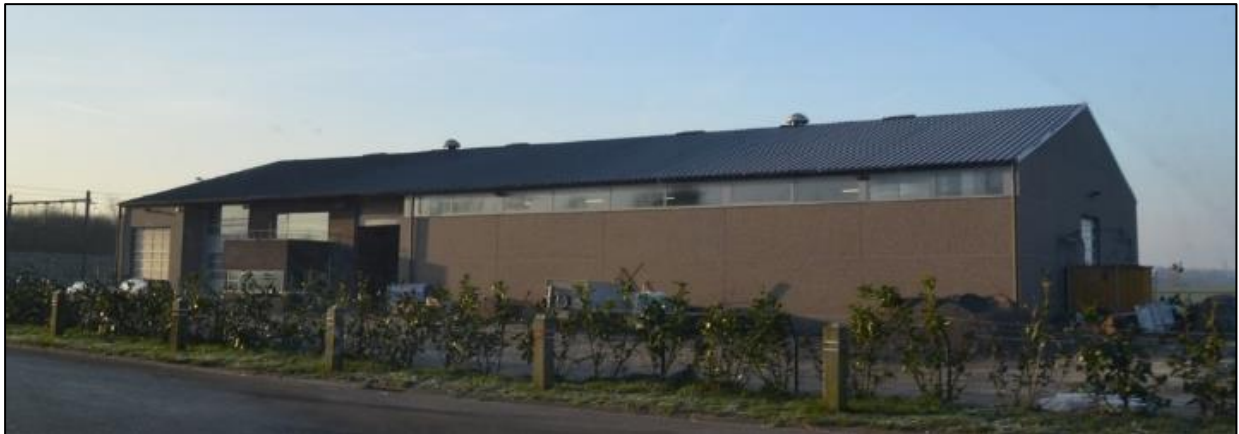
Bâtiment du service travaux © S&A – 2016
