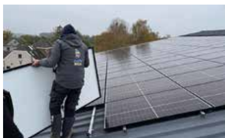
Après avoir remplacé les énergivores projecteurs de la salle des sports par du LED, pas moins de 102 panneaux photovoltaïques ont été installés sur la toiture de la salle SillySports
