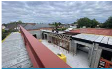
La fin des travaux de la petite salle des sports à vocation scolaire de Thoricourt est annoncée pour fin juin 2023
